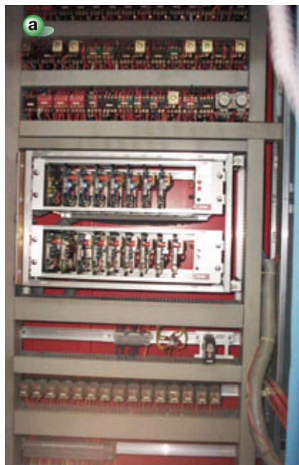
Bild 2 Reglerkarten mit SPS ersetzen
